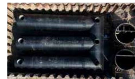
Bassin de tamponnement des eaux usées avec poste de relevage enterré
